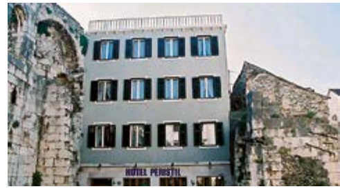
Hotel Peristil Split (Croazia)
